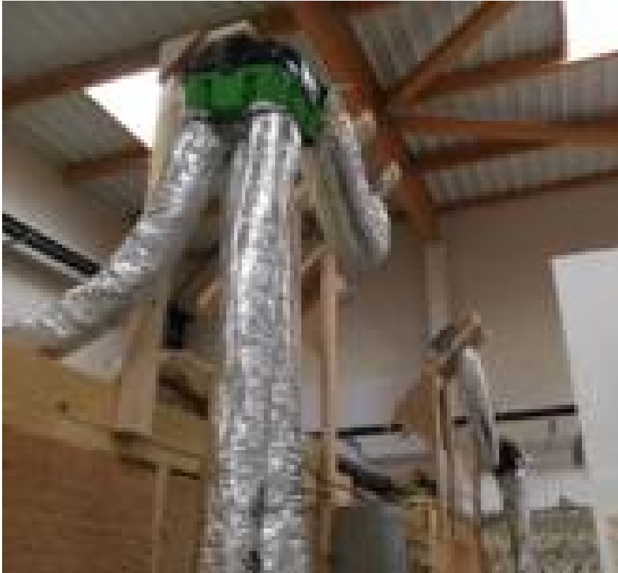
Mise en œuvre d'une ventilation simple flux
