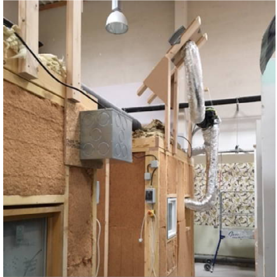
Mise en œuvre d'une ventilation simple flux
