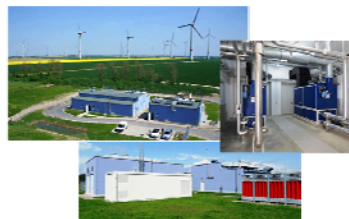
Ex : Hydrogenics en Allemagne 140 MW éolien pour un électrolyseur 1 MW
