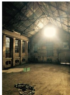
• Salle des machines
