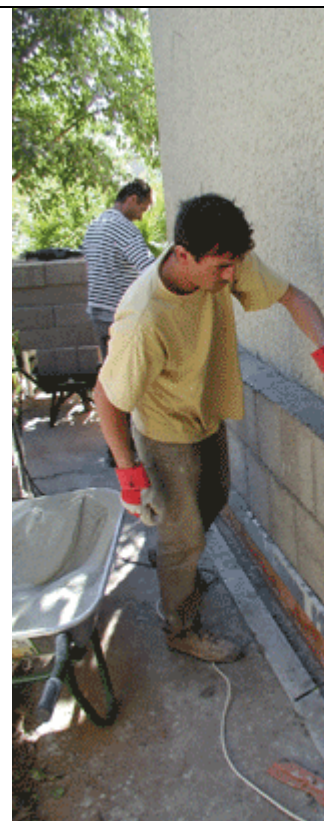
Pose de bloc chaux/chanvre en isolation extérieure
