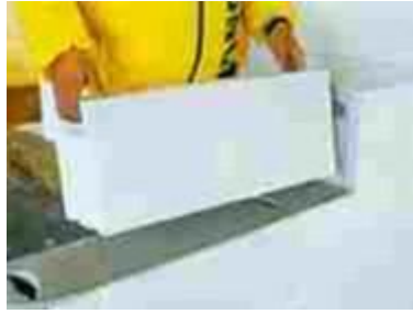
Figure 6 : Pose d'un bloc en béton cellulaire (Source : Xella)
