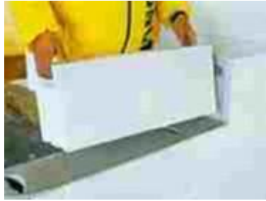
Figure 6 : Pose d'un bloc en béton cellulaire (Source : Xella)
