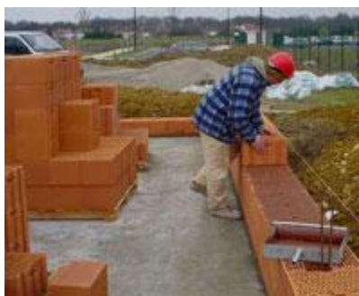
Figure 3 : Pose des monomurs terre cuite (source : Wienerberger)
