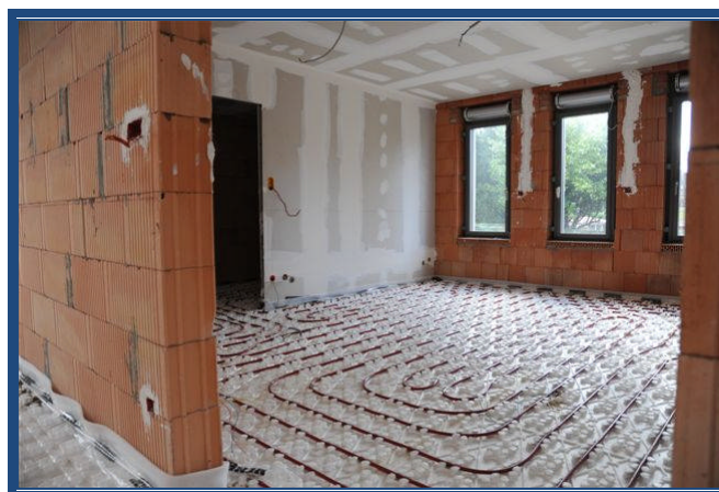
Pose du système de plancher chauffant
