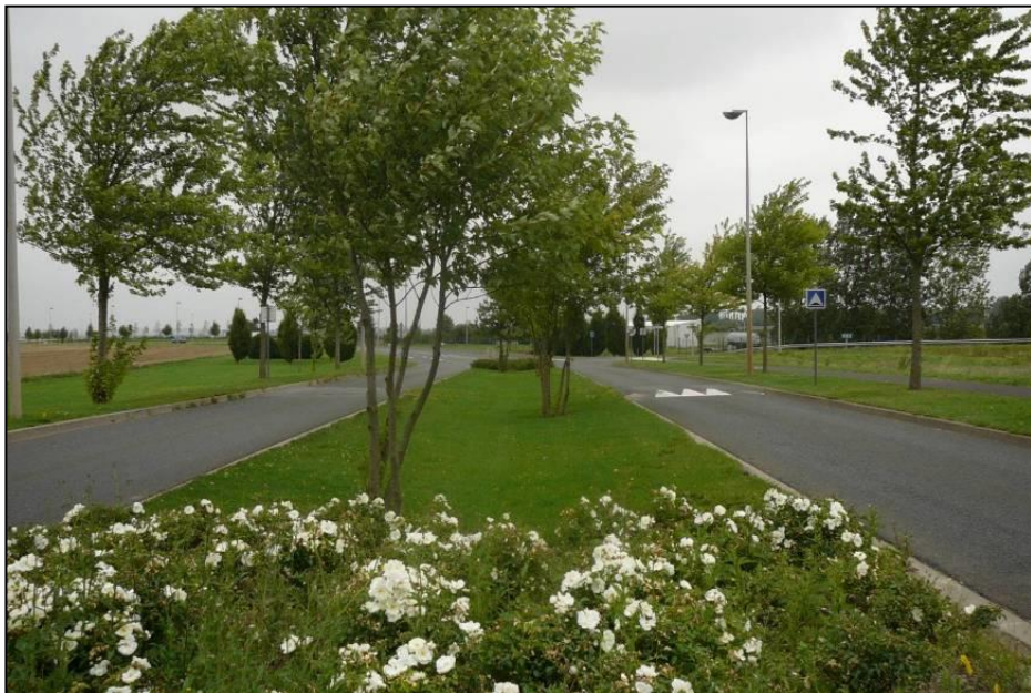
Figure 3 – Deux fonctions pour cette noue engazonnée : espace vert et ouvrage hydraulique
