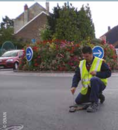
Pose d'un enregistreur de bruit pour la recherche de fuites.
