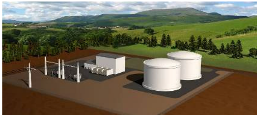
Installation industrielle envisageable de stockage d'électricité sous forme thermique
